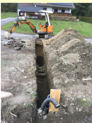
Hausanschluss Alexander Lechner Hammerhofsiedlung
