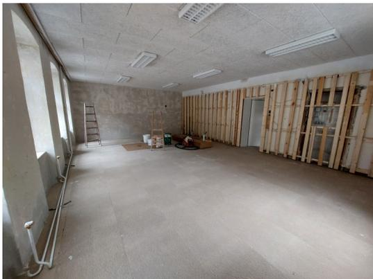
Dabei wurden die Fenstergläser auf Sicherheitsgläser ausgetauscht und die Rahmen neu gestrichen, ein neuer Boden wurde verlegt, die elektrischen Leitungen für eine neue, ballsichere Beleuchtung wurden erneuert, die alten
