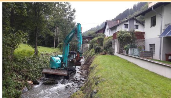
Auf Grund von massiven Auswaschungen im Bereich der Häuser Embst und Günther wurde die Uferböschung des Trattenbach mit Wurfsteinen neu befestigt.
